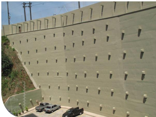
Produzidas em conformidade com os requisitos da norma ASTM A615, as Barras Roscadas ArcelorMittal oferecem alta resistência mecânica, proporcionando vantagens técnicas e econômicas para sua obra. As Barras Roscadas ArcelorMittal são projetadas para atender às mais diversas aplicações em sistemas geotécnicos e estruturais, tais como:
