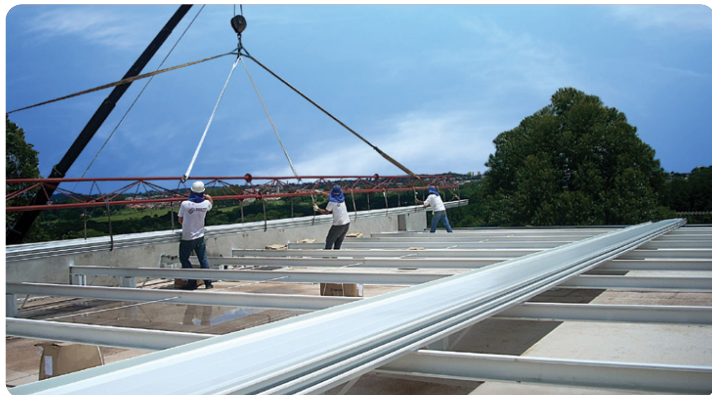
Edifício Educacional - Içamento das telhas
