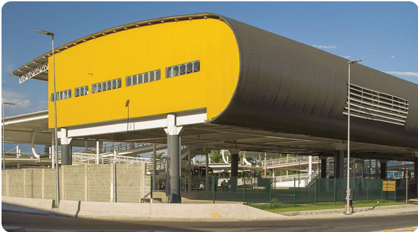
Terminal Sulacap | Rio de Janeiro – RJ Cobertura e Fachada em Telha LR 17 Calandrada Convexa cor Cinza com pré pintura MAX 60 Projeto: Jozé Candido Arquitetos Associados | Foto: Moscow
