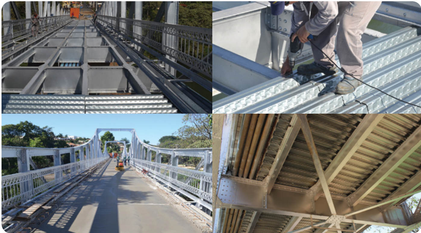
Ponte Euclides da Cunha | São José do Rio Pardo – SP Retrofit com Forma Colaborante Polydeck® 59S – Steel Deck Projeto: Projetta (retrofit) | Foto: Perfilor
