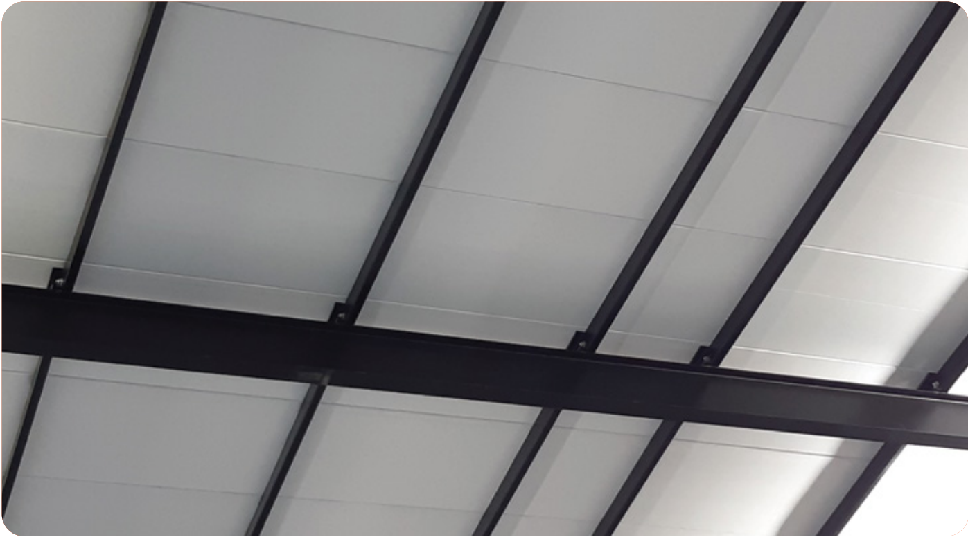
Galpão Industrial (vista inferior) | Taubaté - SP Termilor Filme® – TR 63-TF, com filme de alumínio na cor Branco
