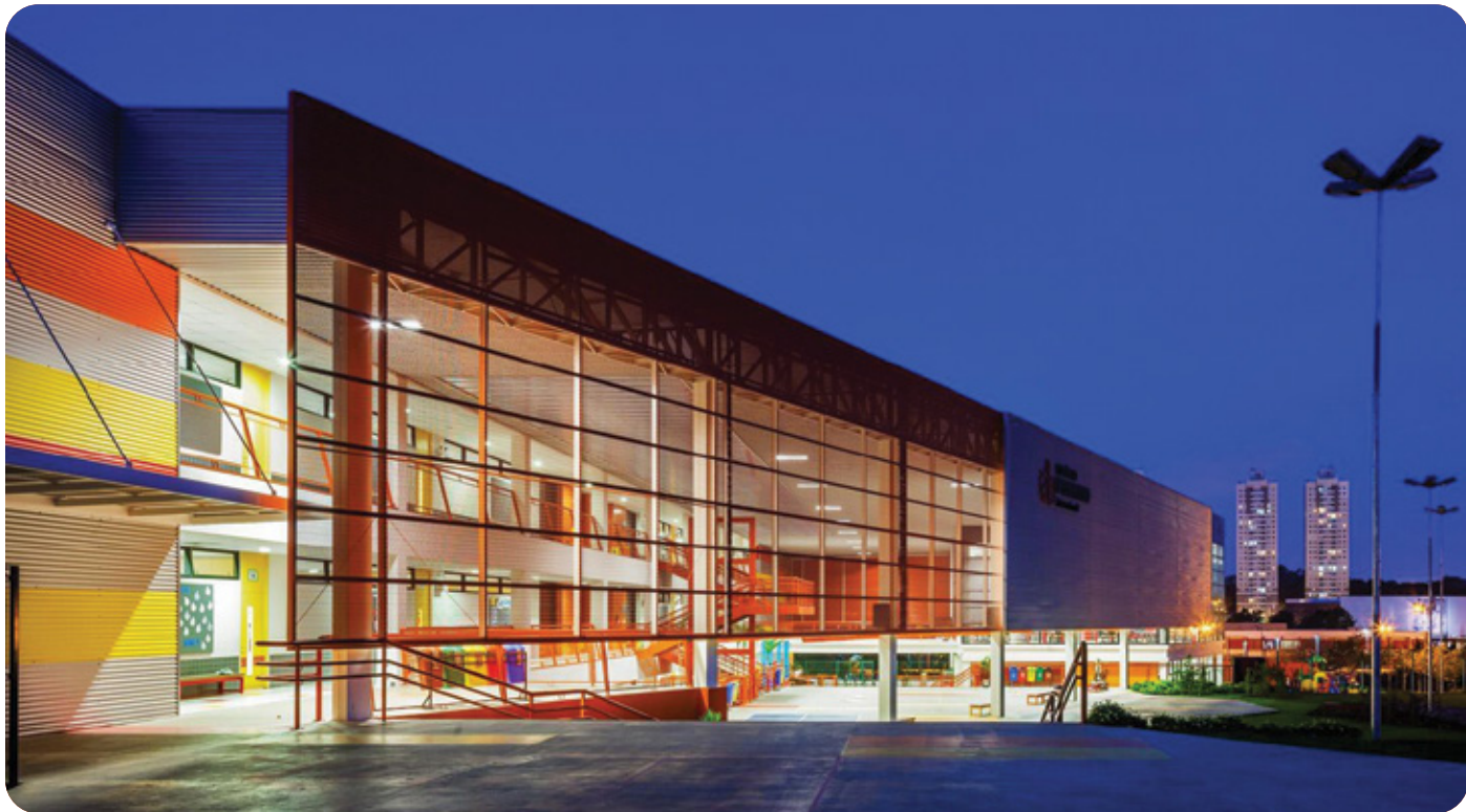
Colégio Positivo | Curitiba - PR Fachada em Telha Ondulada LR 17 Perfurada Totalmente (13,64%), na cor Laranja Telha Ondulada LR 17 sem perfuração nas cores Amarelo, Prata e Laranja
