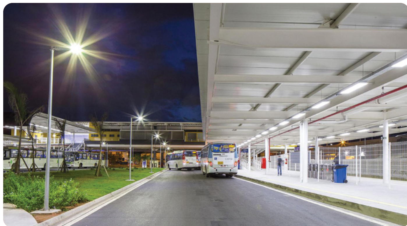
Terminal Sulacap | Rio de Janeiro - RJ
