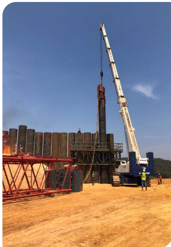
Martelo vibratório suspenso em guindaste
